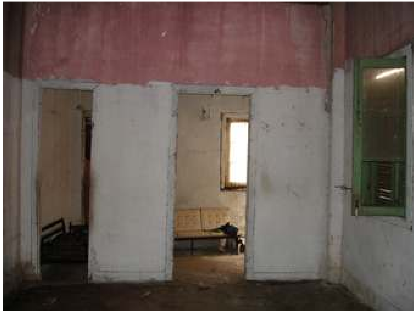
ÁREA INTERNA PRIMEIRO VOLUME Internamente, o espaço é dividido por paredes estreitas de estuque.
