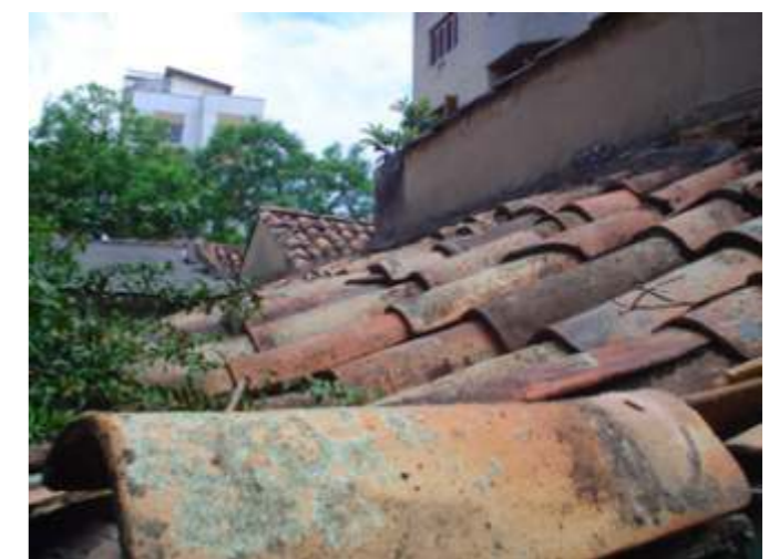
TELHADO SEGUNDO VOLUME Telas tipo capa-e-canal cobrem o volume dos fundos.
